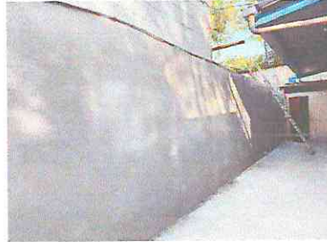
Foto 4: pared exterior de aula con aplicación de monocapa gris.
