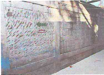
Foto 3: pared exterior de aula picada, previo a la aplicación de monocapa y pintura.
