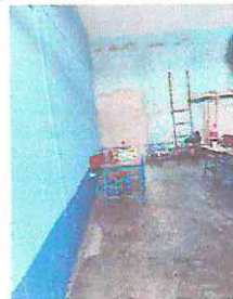
Foto 6: proceso de reparación interior de aula.
