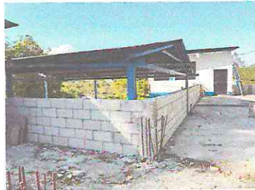
Foto 2: bordillo terminado en terraza, previo a la aplicación de monocapa gris y blanco.
