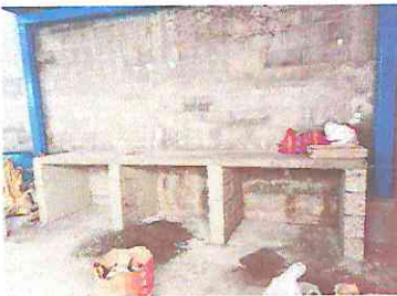
Foto 5: fabricación de mesón, previo a la aplicación de pintura.
