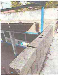
Foto 1: proceso de levantado de bordillo en terraza.
